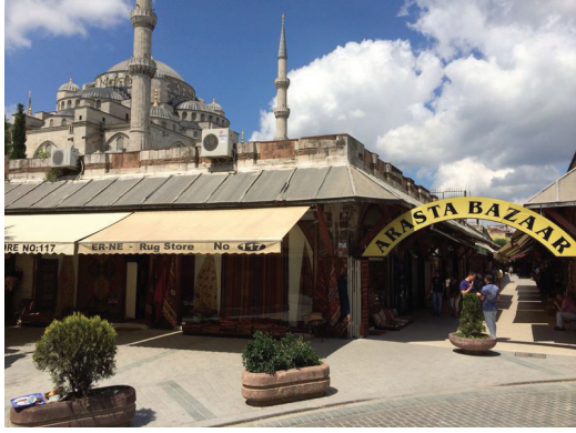
Sultan Ahmet Külliyesi Arastasi
