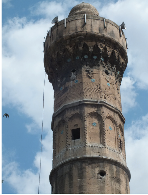
İbrâhimiye Medresesi minaresi
